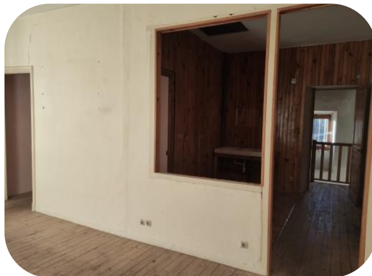
Avec la salle de bain en haut de l'escalier...
